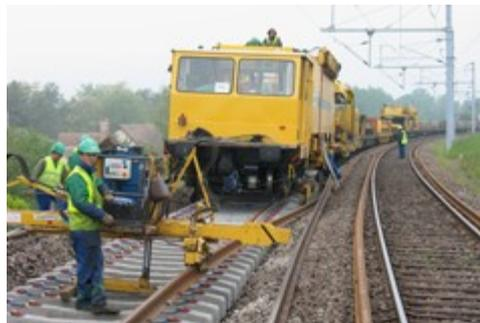
Longs Rails soudés sur traverses béton
